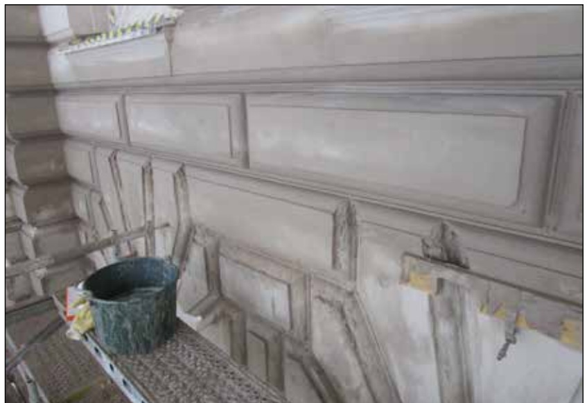
Listdragning i kalkbruk. Foto: Simon Patetsos, TP Mur & Puts AB
