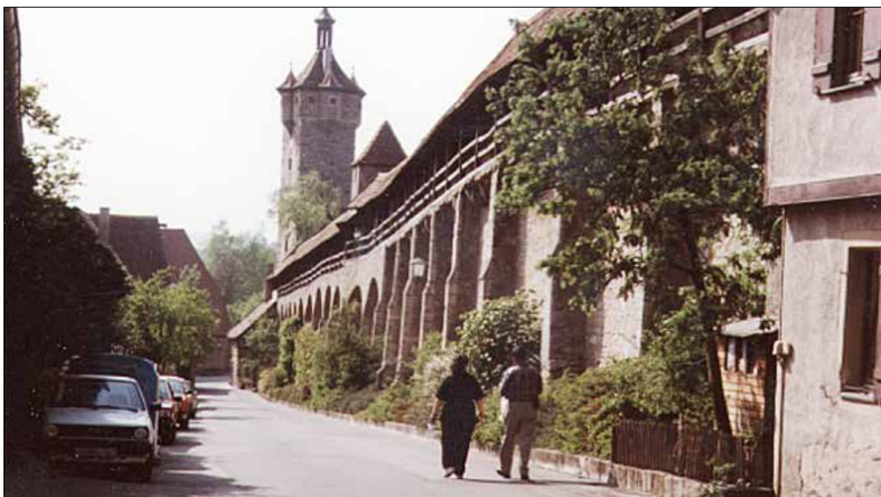
Elastiskt murverk som skyddas under fredstak.
