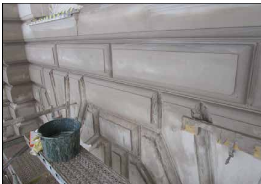
Listdragning i kalkbruk. Foto: Simon Patetsos, TP Mur & Puts AB
